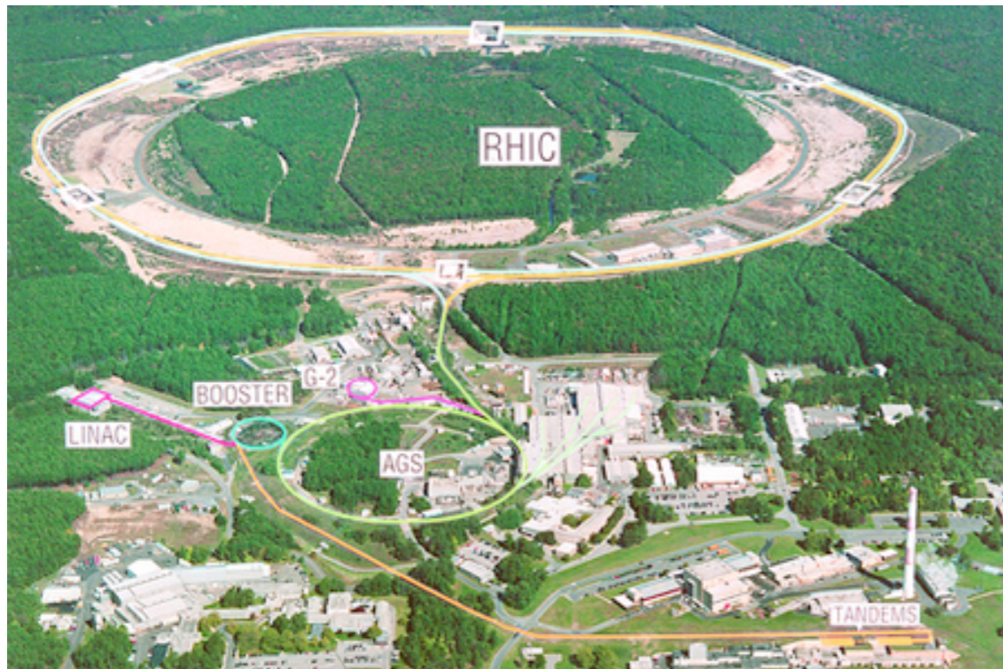
Brookhaven National Laboratory, EEUU
