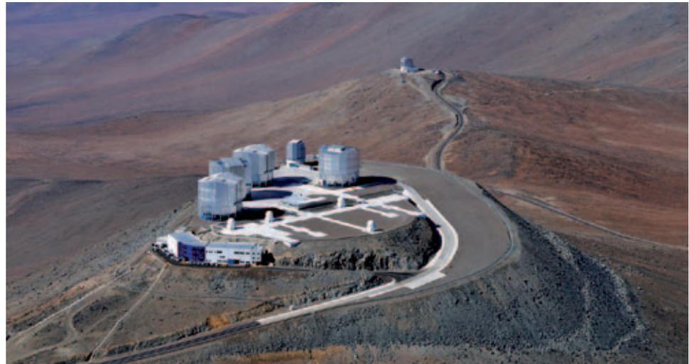
**Foto 2.** Imagen aérea del Observatorio VLT (Very Large Telescope) del Observatorio Europeo Austral (ESO), situado en Cerro Paranal (Chile). Pueden distinguirse los cuatro telescopios de 8,2 metros junto con los telescopios auxiliares de 1,8 metros. Disponen de instrumentación en el óptico e infrarrojo y pueden funcionar interferométricamente. Fuente: material gráfico cedido por el autor.
