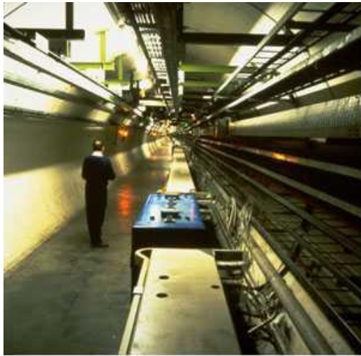
Figura 14: Túnel con la maquinaria del LEP
